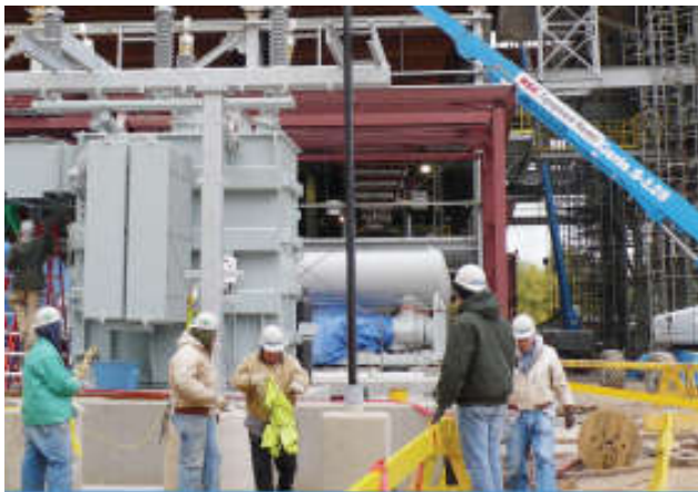
HV cable pull.
